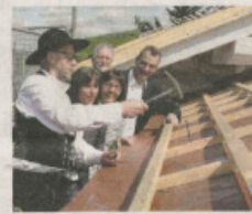
Achtung! Der Zimmermann versenkt den letzten Nagel im Dachstuhl.
