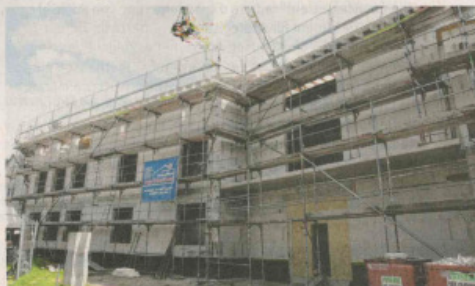
In Kürze werden bereits die Fenster in den Neubau eingesetzt. Das Projekt vollzieht sich pünktlich nach Zeitplan.
